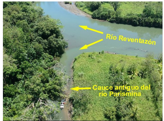
Figura 6. Incurción de aguas del río Reventazón por la antigua boca del río Parismina
